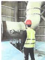
◎24DA025 熟料库顶排放口 24#
