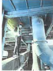
◎DA006 1#散装机排放口 6#
