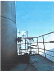
◎27DA028 煤磨排放口 27#
