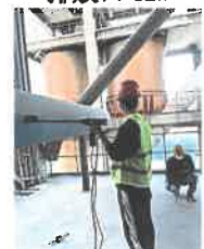
◎17DA017 生料库排放口 17#
