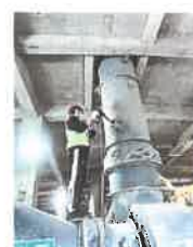
◎4DA004 3#包装机排放口 4#
